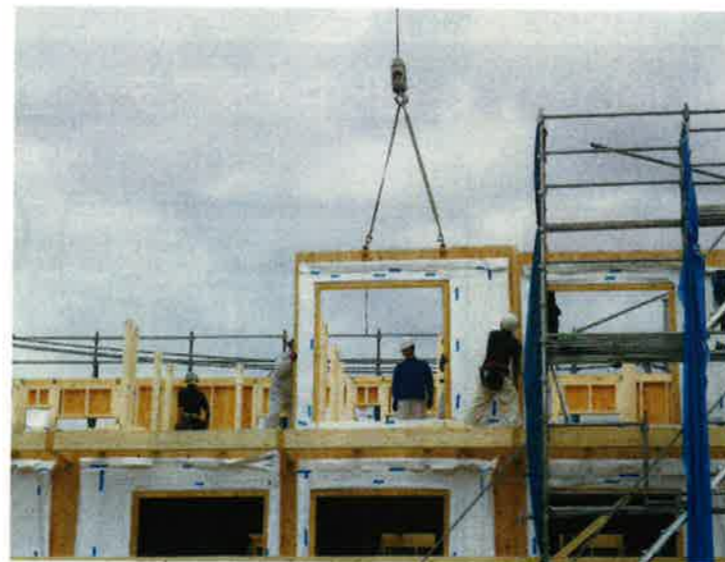
パネルは所定の位置に設置し、ピンでとめる
