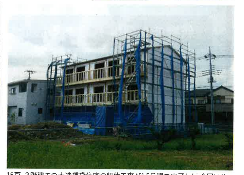
15戸、3階建ての木造賃貸住宅の躯体工事が1.5日間で完了した。今回はサッシ、断熱材は後付けだが、組み込みの場合でも現場の作業は同じ
