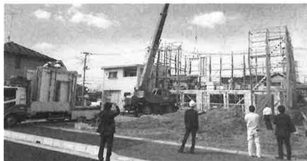
2階部分のパネル施工を終えるまでに1時間もかからなかった
