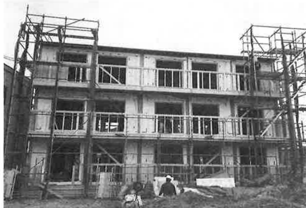
建て方の開始から1日半で3階までのパネル施工を完了。2日目の午後には雨仕舞い工事までを終えた
